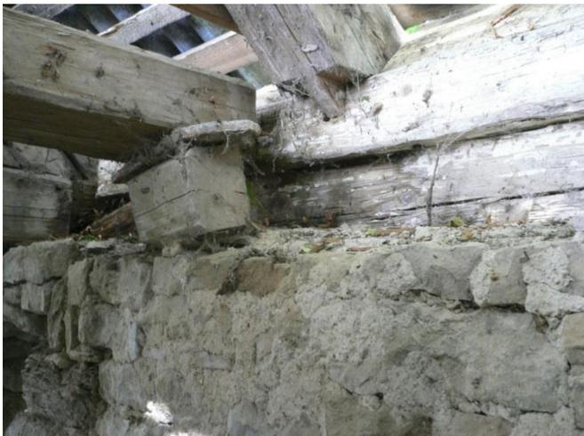
Der Dachfuss ist auf eine Art gestaltet, die sich in unserer Gegend häufig, in der übrigen Schweiz aber kaum findet: zwischen den Bindern sind die Sparren in ein auf dem Mauerbalken liegendes Längsholz quer eingezapft. Das Längsholz ist mit einem senkrecht stehenden Zapfen in den Binderbalken seitlich eingelassen, so dass es, solange die Köpfe der Binderbalken intakt sind, nicht nach aussen weichen sollte.
