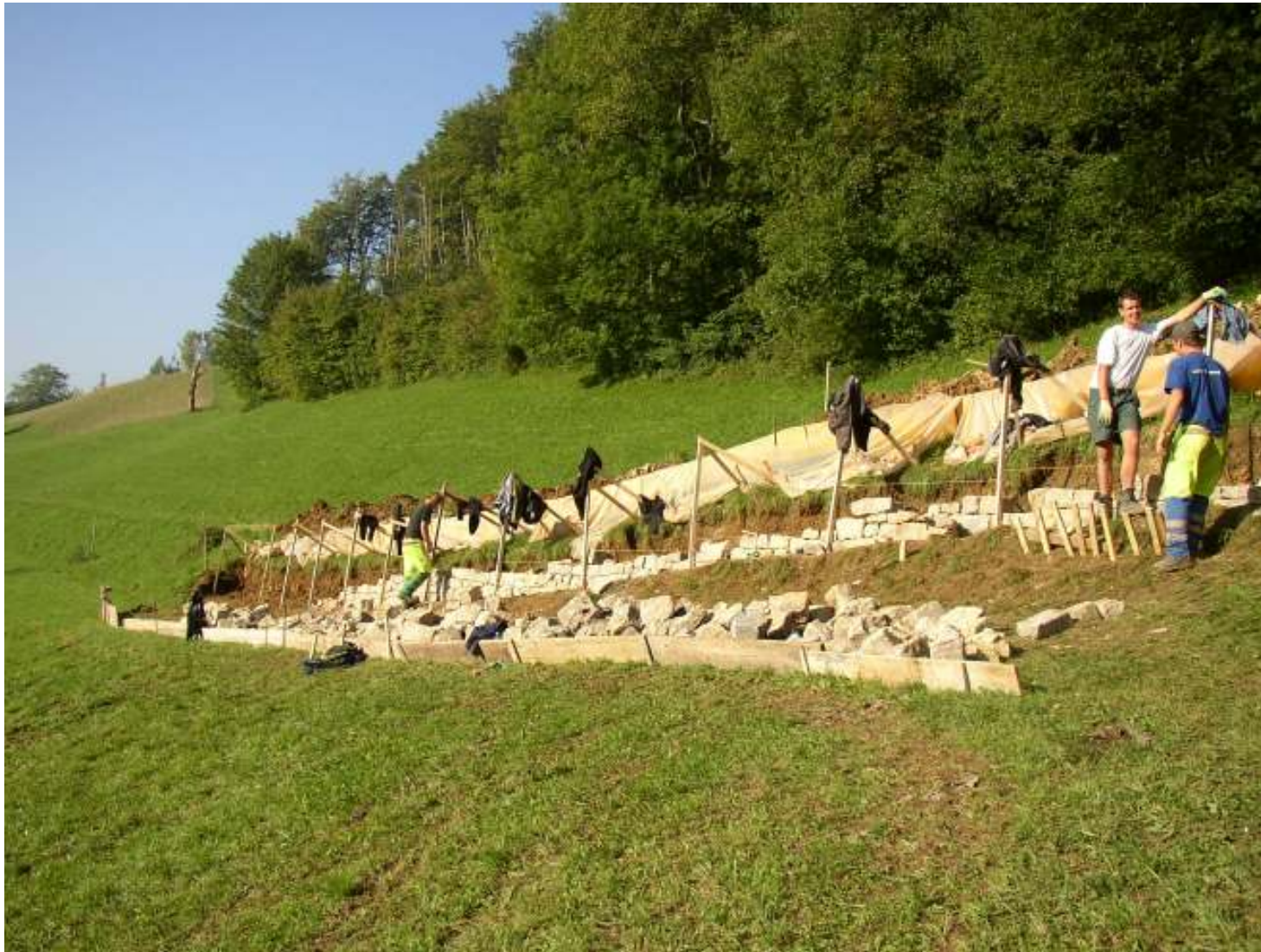
Projekt: Trockenmauern Rothenfluh
