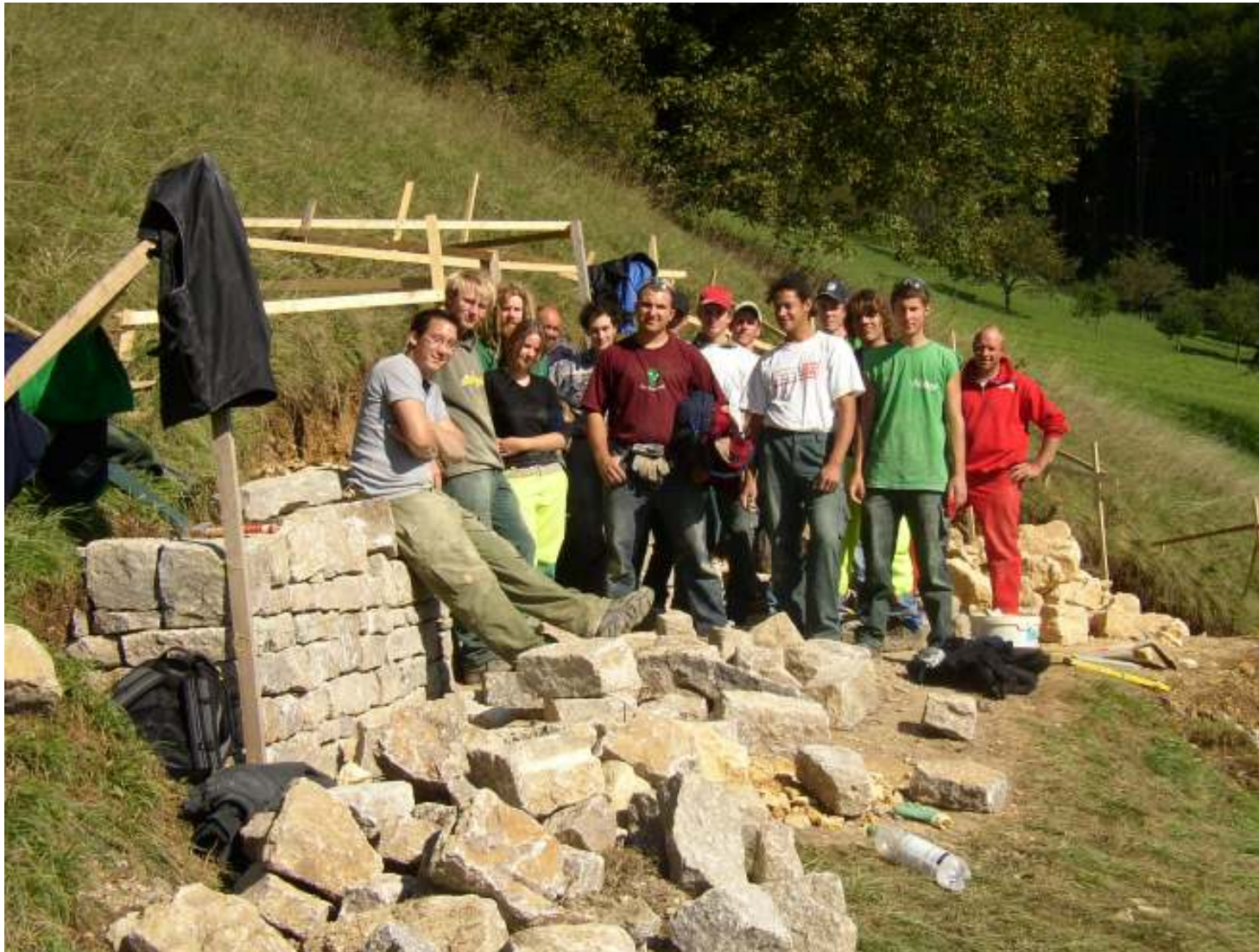
Projekt: Trockenmauern Rothenfluh
