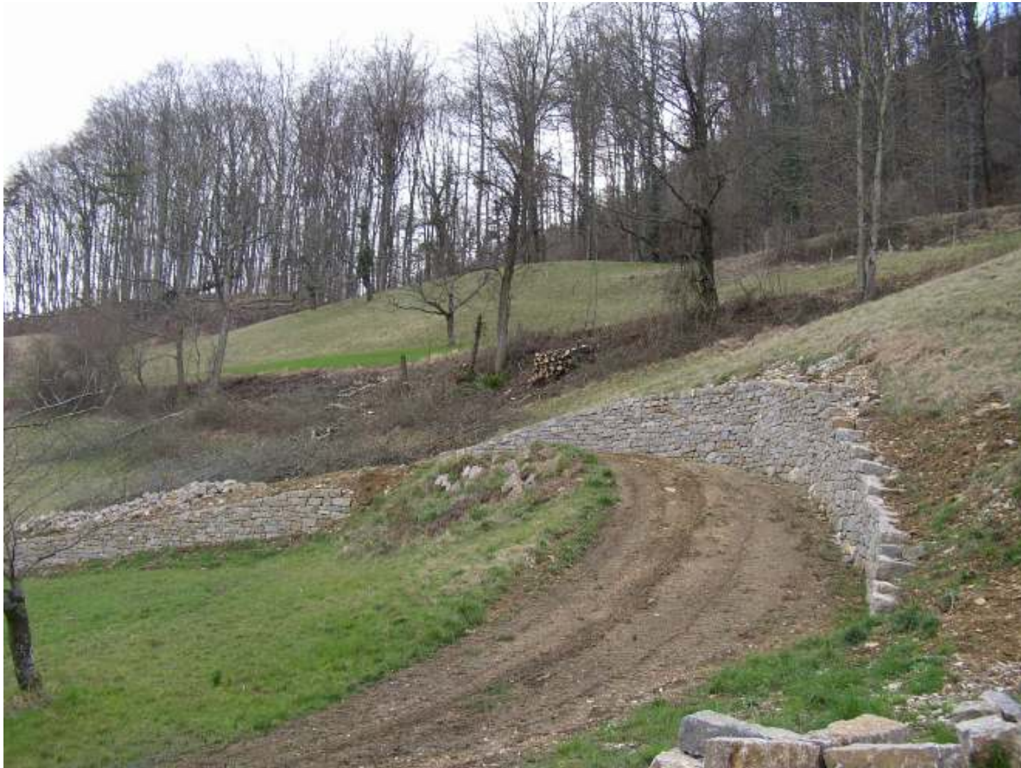
Projekt: Trockenmauern Rothenfluh
